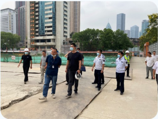
生产建设项目水土保持监督检查
