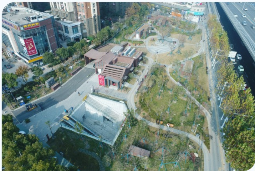
中皓常青五路停车场项目
