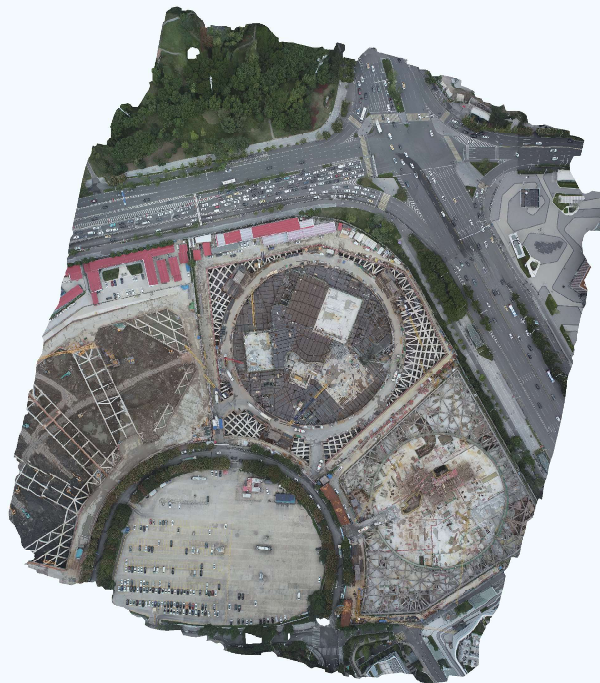
武汉广电全媒体中心项目航测拼接图
