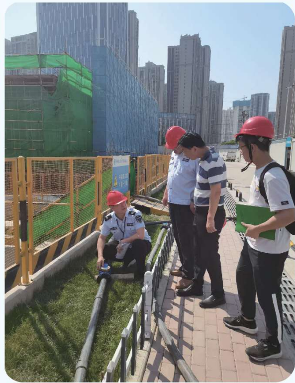
生产建设项目水土保持监督检查
